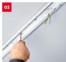
**02** Führen Sie das Netzkabel durch die Kabeleinführung und befestigen Sie die Bodenplatte an der Montagefläche.
